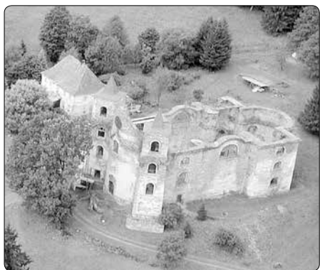
Kostel v Neratově po zřícení kleneb, ke kterému došlo roku 1957
