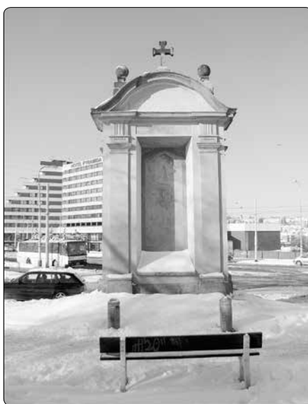
Praha, Břevnov - ulice Gymnastická, výklenková kaple na poutní cestě z pražské Lorety do kláštera v Hájkách. (V pozadí hotel Pyramida)
