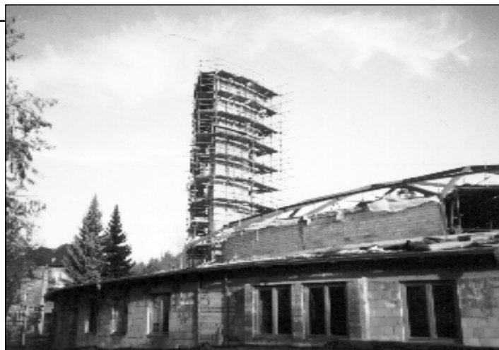
Věž nového farního kostela v Luhačovicích bude vysoká 27 metrů (foto: Vojtěch Cěkota)
